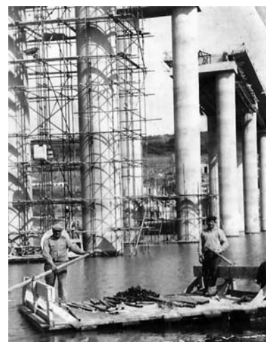
Costruzione Viadotto Lago Omodeo, si riconosce Gavino Piras
